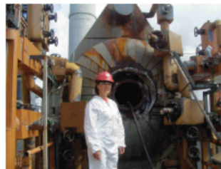
Uzdatnianie w kotłach
